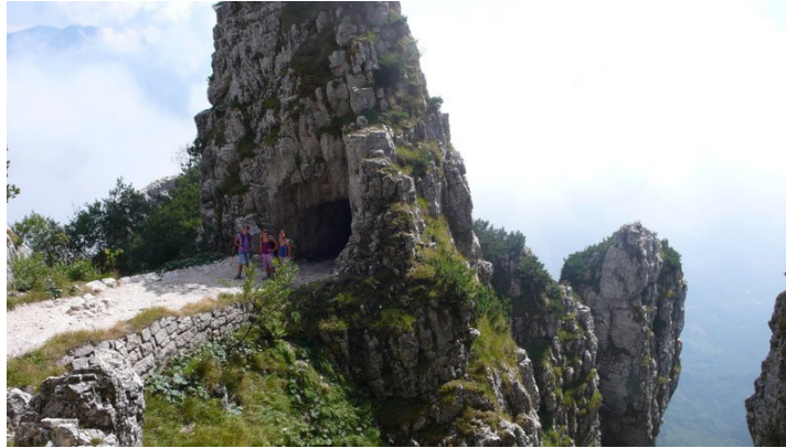
Strada delle 52 gallerie
