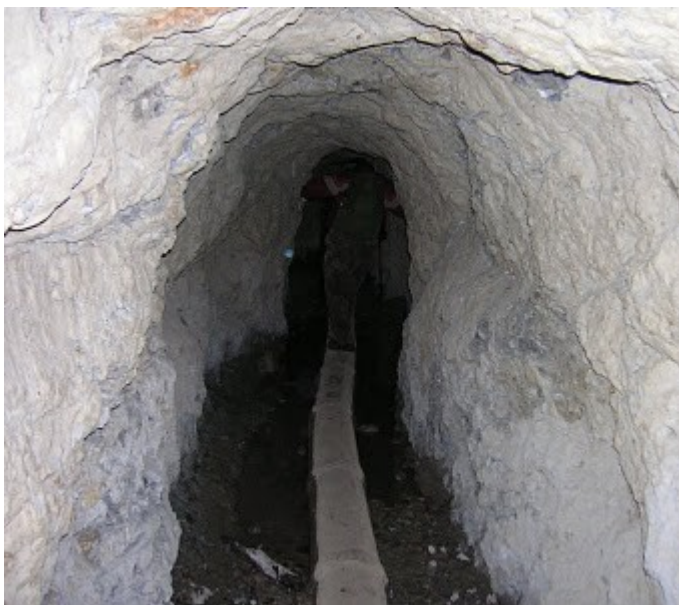
Una galleria dell'acquedotto
